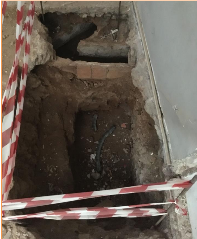
Foto 1. Vista general de la cala 1.
