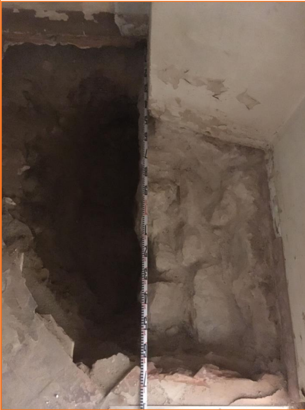
Foto 3. Vista general de la sala 3.
